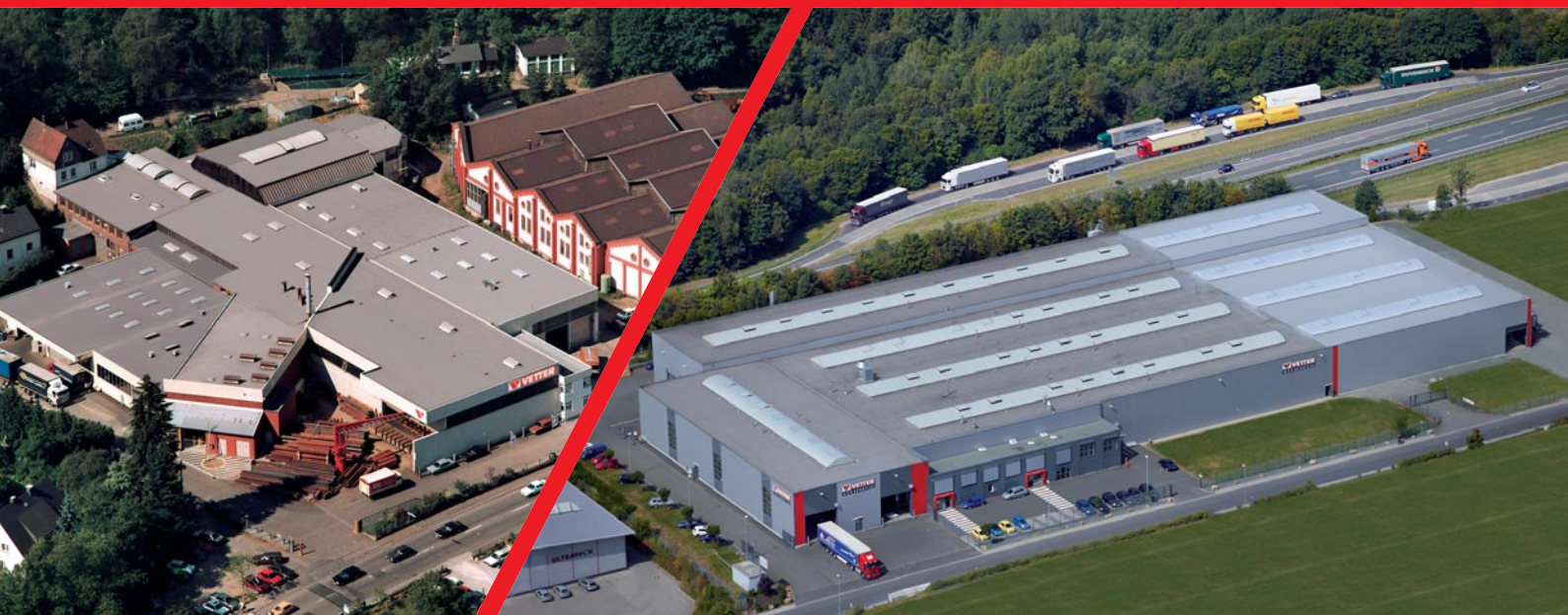
Stammwerk Siegen Headquarters Siegen
